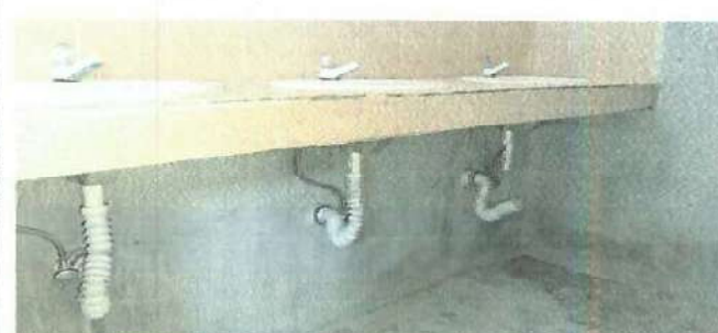
Foto 4: Suministro e instalación de accesorios nuevos para 6 lavamanos, incluyendo llaves, desagües, sifones y demás elementos necesarios para su correcto funcionamiento.
