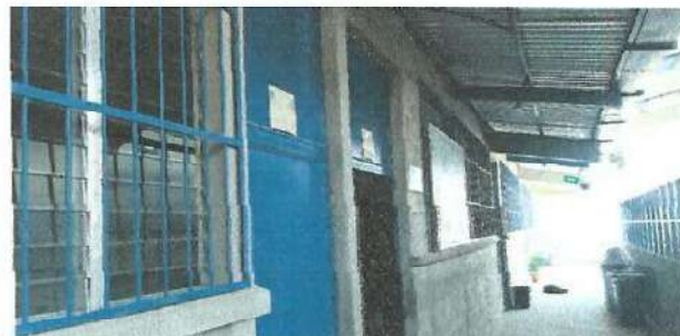
Foto 2: Mejoramiento de pintura a base de aceite en zócalo del módulo de aulas, así como en paredes interiores y exteriores de los servicios sanitarios
